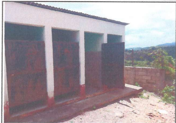
REPARACION DE PUERTAS METALICAS Y MEJORAMIENTO E INSTALACION DE AZULEJOS DE LOS BAÑOS
