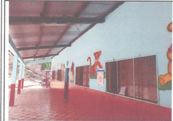
REPARACION Y MEJORAMIENTO DE PUERTAS Y VENTANAS DE AULAS Y COCINA
